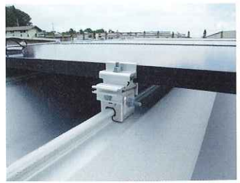
産業用(ハゼ折板用)フラットグリップ金具の施工写真
