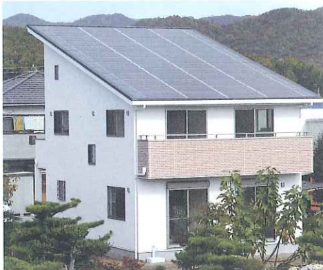
屋根一体型モジュールの設置事例
