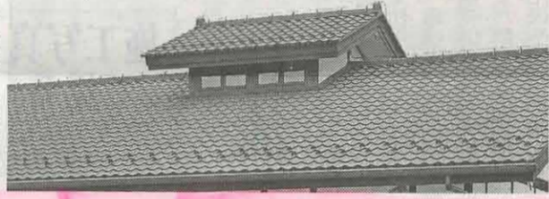
和風屋根への施工例
