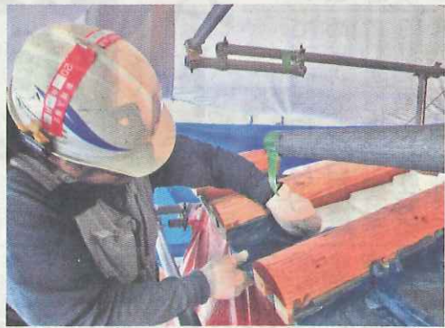
10月中旬から葺き替え工事が始まった
