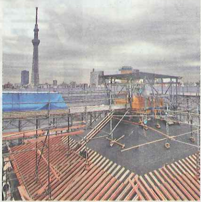
最高部から望む工事現場の様子
