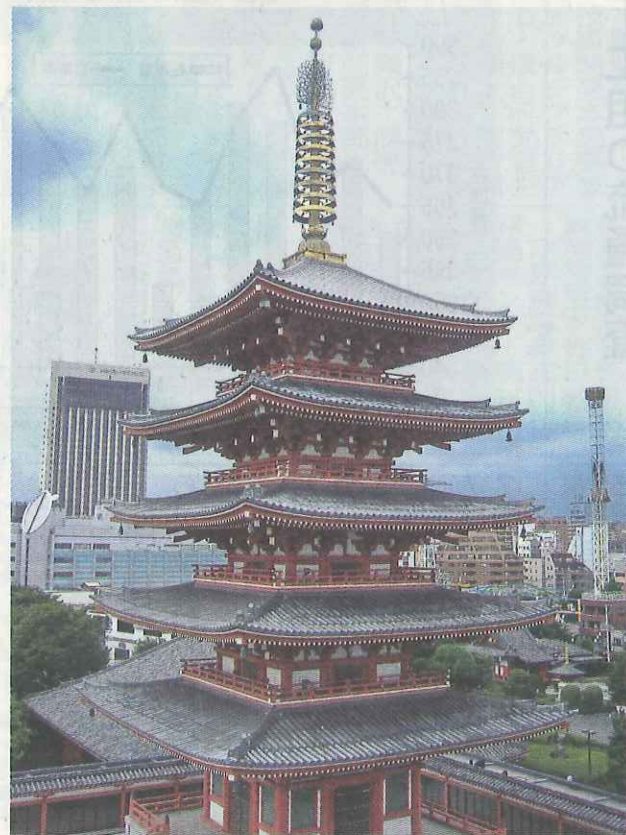
屋根改修前の五重塔
