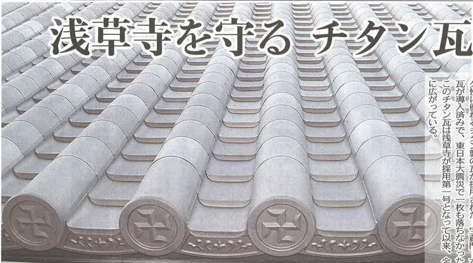
浅草寺本堂のチタン瓦屋根。五重塔の屋根のふき替えにも同じ瓦が使われる。(いずれもカナメ提供)
