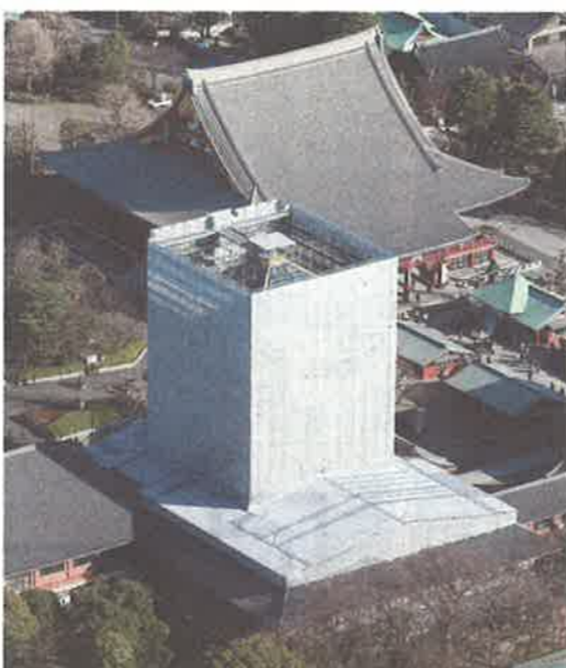
工事のため囲いに覆われた浅草寺五重塔。奥は本堂=12日、東京都台東区で(本社へ「まなづる」から)
