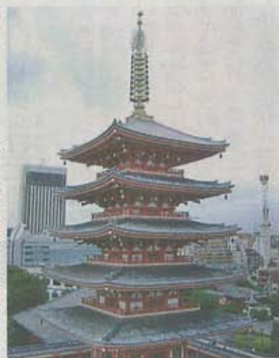
チタン瓦に改修される浅草寺五重塔
