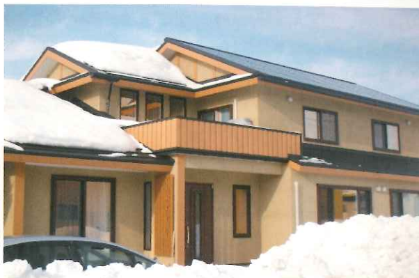
屋根一体型太陽光パネルは金属屋根と比べても雪を滑り落としやすいという
