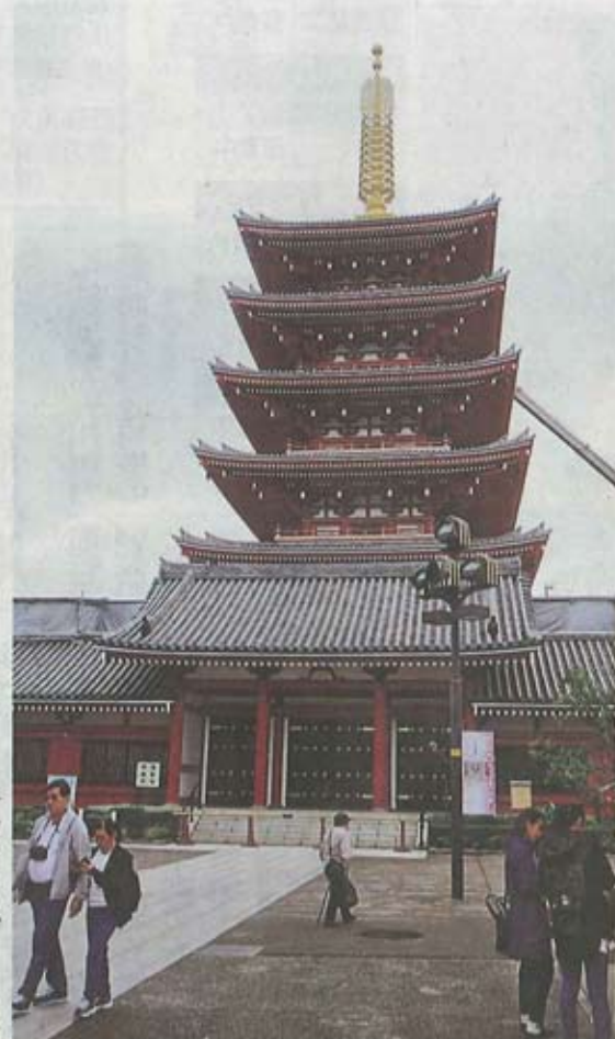
会津発のチタン瓦にふき替えられた五重塔
