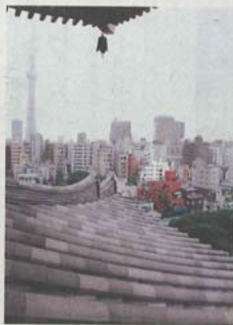
カナメ喜多方工場製のチタン瓦を採用した五重塔の屋根①
