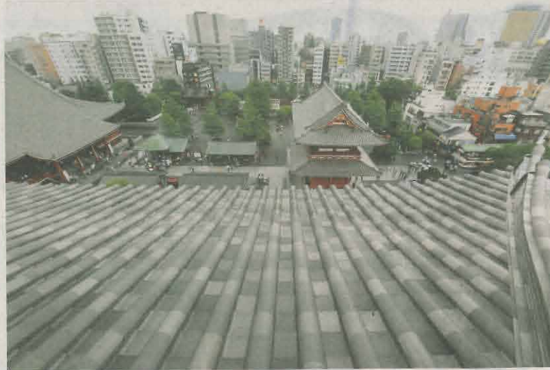
チタン製の屋根瓦へのふき替え工事が完了し、報道陣に公開された浅草寺・五重塔の屋根(手前)。すでにチタンが使われている本堂(奥左)と宝蔵門(同右)が見える=13日午前、東京都台東区
