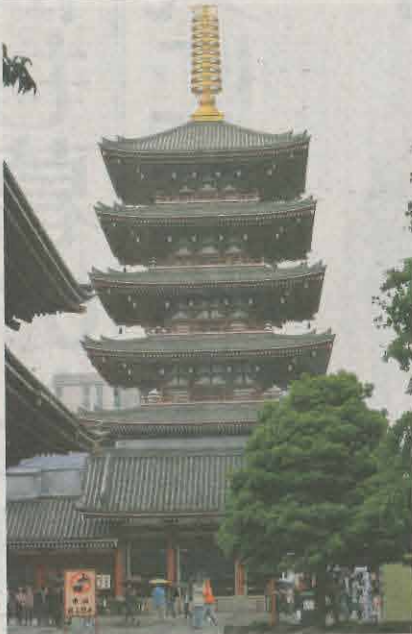
屋根瓦のふき替え工事が完了し、公開された浅草寺五重塔。13日午前、東京都台東区
